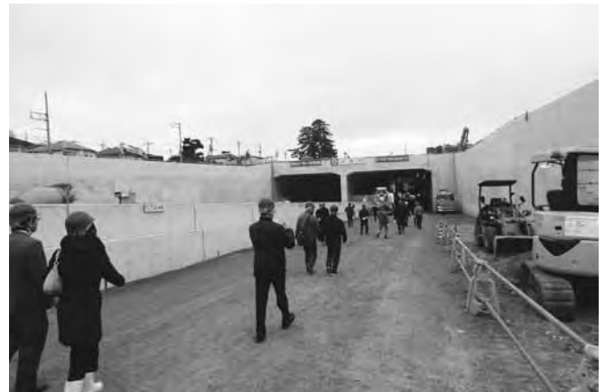
【写真1】外環・市川中工事現場：掘割部から地下に入る一般国道部分のトンネル
