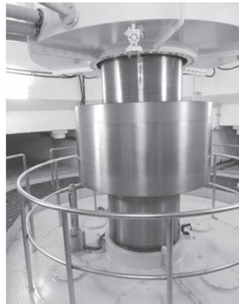
関西電力黒部川第四発電所の独フォイト製水車(左)と発電機の主軸
