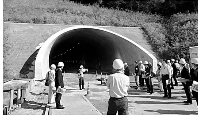
前山トンネルの工事現場で施工関係者から説明を受ける視察参加者
